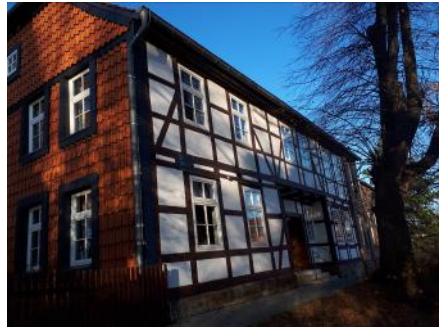
Sanierung der Südfassade am Pfarrhaus
